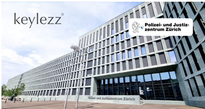
Haupteingang des Polizei- und Justizentrums Zürich
